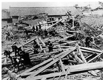
倒壊した網野小学校
