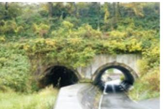
メガネトンネルは県道と和田川を横断するトンネルです。山陰線の建設当時、レンガ造りが一般的でしたが、このトンネルは当時では珍しい鉄筋コンクリート造りです。建設時の写真では多くの鉄筋が組まれ、最先端の技術でつくられたことがわかります。
