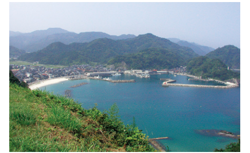
リアス海岸を利用した風待ち港
