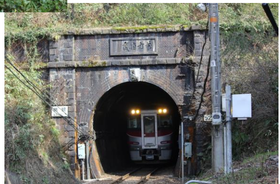
桃観トンネル
