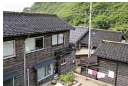
焼杉板を横にはり、棟石に凝灰岩を使った家屋
